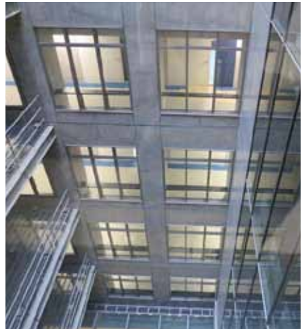
研究棟吹抜け
